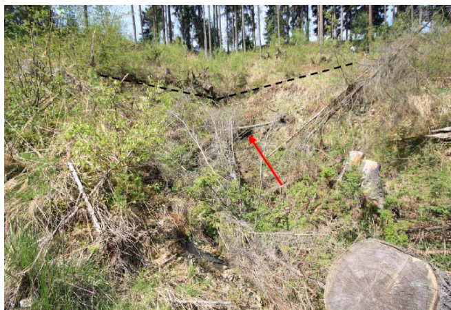
Abb. 1 Vordersicht des verbrochenen Einganges in einen Grubenbau
