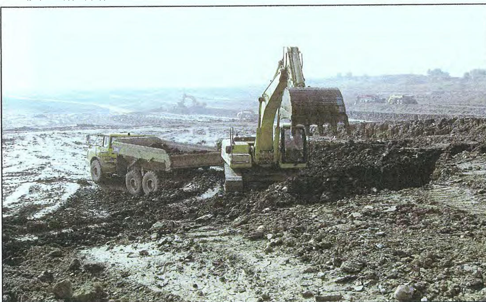
Těžba těsnících materiálů
