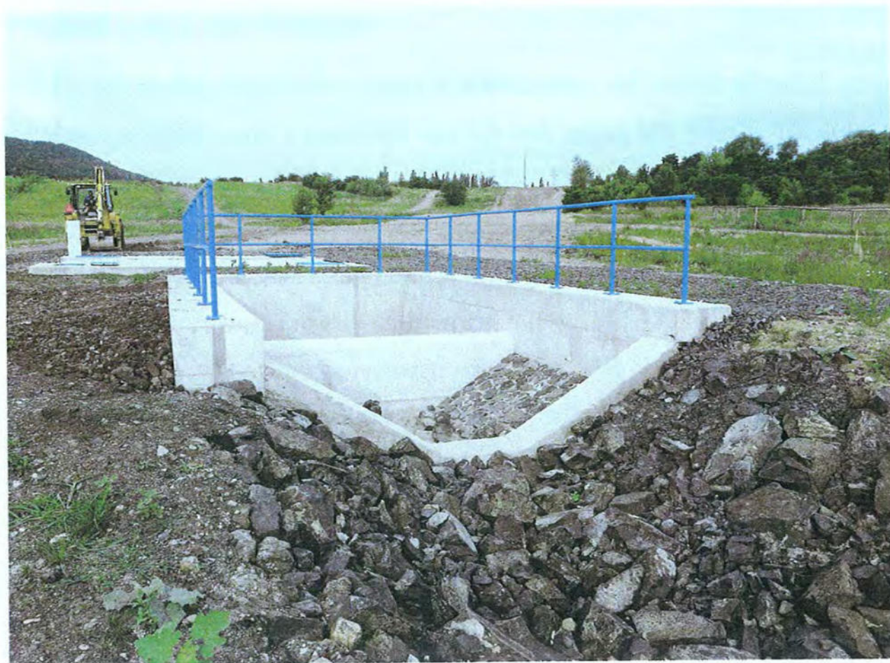
Uklidňovací objekt, v pozadí regulační šachta
