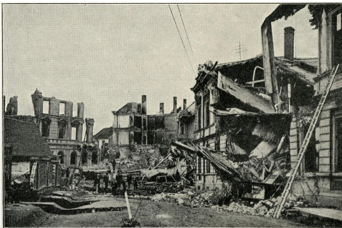
Abbildung 1: Propad severního předměstí města Mostu 20. července 1895 v důsledku vniknutí kuřavek do hlubinného dolu, které bylo zapříčiněno porušením hydrologického režimu (historický snímek, KARL PIETZNER, Teplice)
